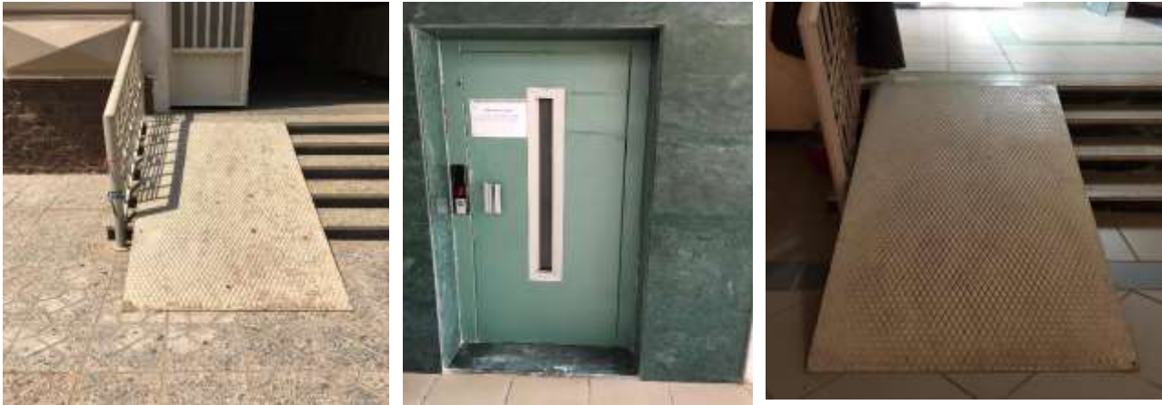
مصعد كهربائي ومنحنيات صعود و (Ramps)
